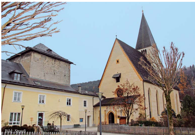
Der freie Blick auf die Pfarrkirche und den Kastenhof soll erhalten bleiben.
