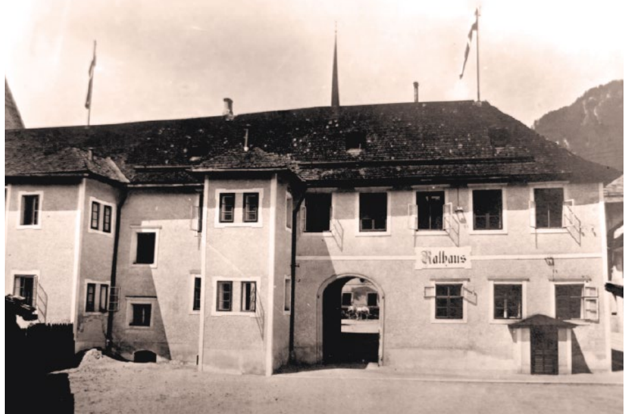
Rathaus mit Durchgang zum Kastenhof von Osten
